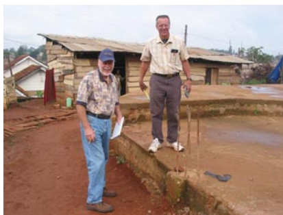
Grunnmuren til kirkebygget i Kampala på plass. Gamle-bygget i bakgrunnen. Det gjenstår snau 1 mill kr til å fullføre byggeprosjektet i Uganda. Gaver kan merkes "Ugandaprojektet".
