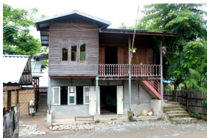
Den opprinnelige bygningen ved døveskolen i Kalay. Den huser soverom, et klasserom og rektors leilighet. Utvidelser trengs til flere klasserom og mer sengeplass.
