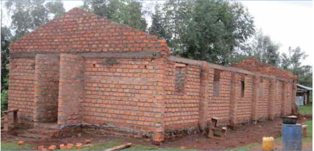
Nytt elevhjem under bygging for guttene ved skolen i Ringa, Kenya
