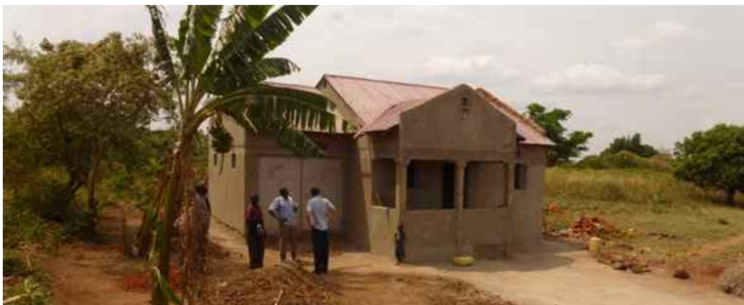
Huset til Dennis er nå ferdig takket være norsk støtte
