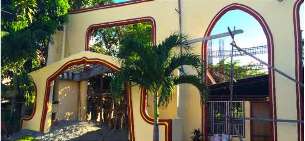
Davao DMI. Fasaden på tilbygget ser fin ut, men mye gjenstår bakenfor.
