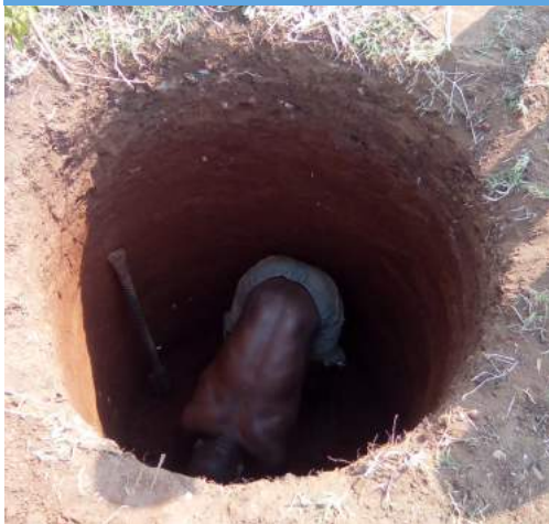
Ny borehull i Malawi
